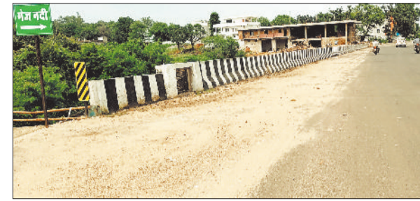
पुल के एप्रोच सड़क पर हुआ मरम्मत कार्य।
